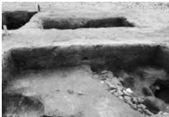
6. 16トレンチ西壁
