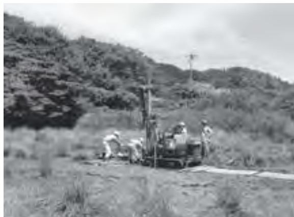
写真4 ボーリング調査風景（第6次調査）
