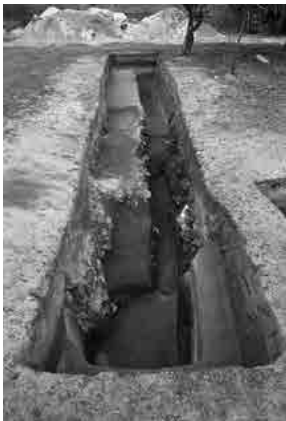
1. 6トレンチ攪乱坑完掘状況(北から)
