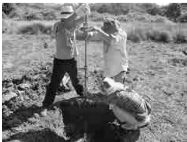
写真14 ボーリング調査風景 (3次調査)
