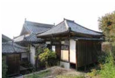
【建造物】 東泉寺薬師堂
