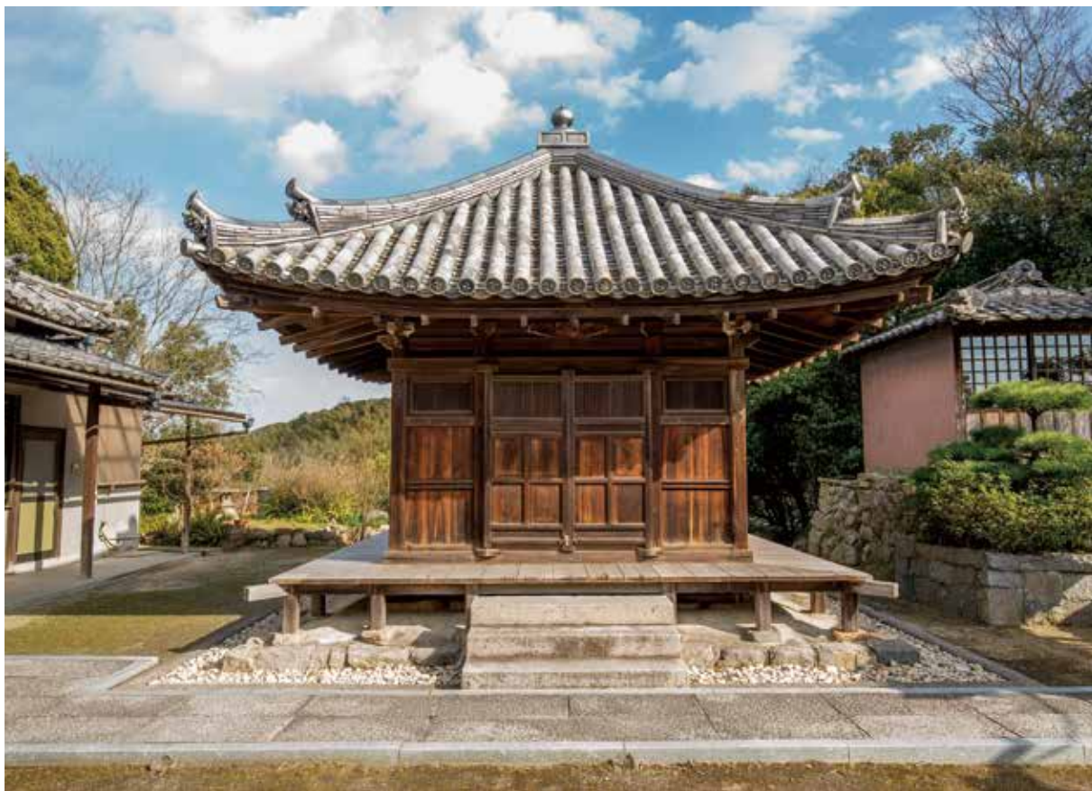
2 定光寺観音堂（西北西から）
