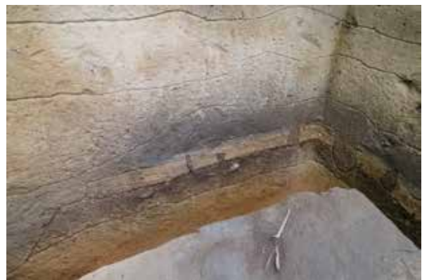
高浜八幡神社 浜床断ち割り状況
