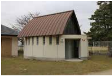
【便益施設】トイレ（町管理）
