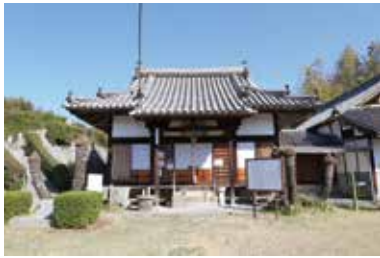
【建造物】外陣（礼堂）
