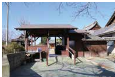
【便益施設】 トイレ・休憩所（寺管理）
