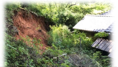
(岩城地区)小漕 D 地区がけ崩れ防災対策箇所
