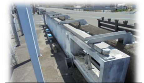
(岩城地区)長江港海岸陸閘改修
