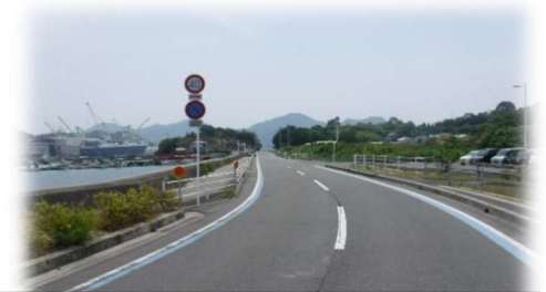
(生名地区)立石港利用車両待機レーン増設
