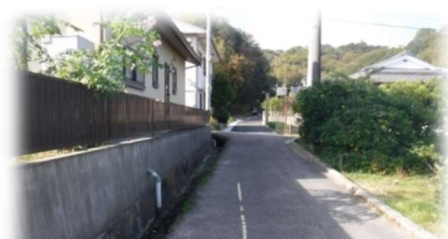
(生名地区)町道中側中後水路改修工事
