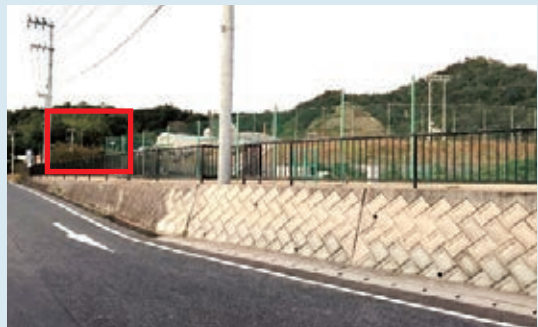
トイレ新設予定場所
