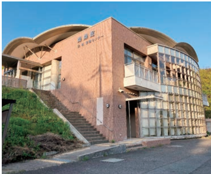
事務所が無人化した岩城保健センター
