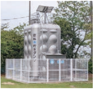
完成した佐島耐震性貯水槽
