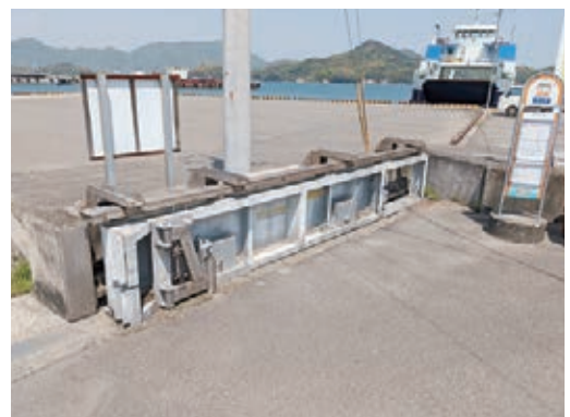
改修予定の長江港陸閘
