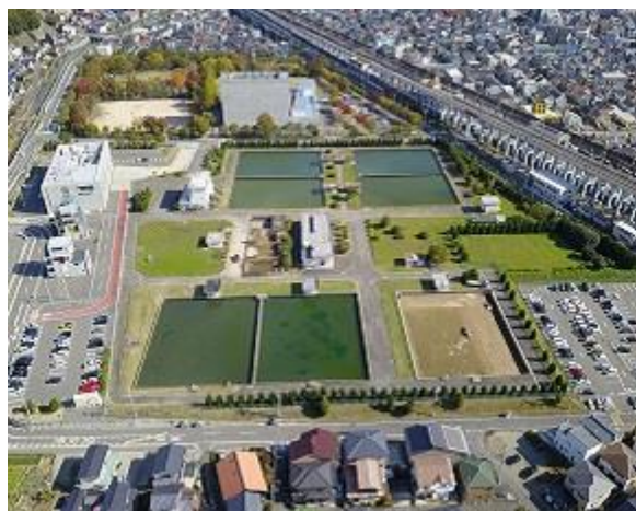
図 2-7 宮浦浄水場（広島県沼田川用水供給事業）
