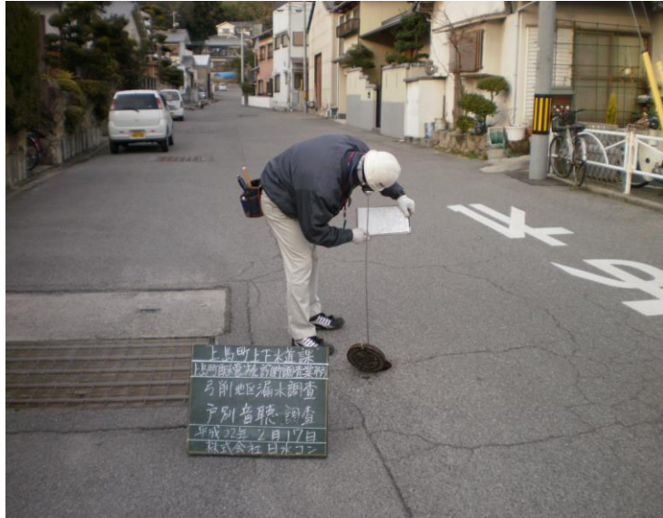
図 3-7 漏水調査の様子
