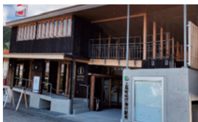
更なる活用が期待される海の駅舎
