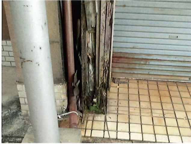
②基礎に不同沈下のあるもの、柱の傾斜が著しいもの、はりが腐朽し、又は破損しているもの、土台又は柱の数ヶ所に腐朽又は破損があるもの等大修理を要する。(50点)
