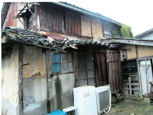
②屋根ぶき材料に著しい剥落があるもの、軒の裏板、たる木等が腐朽したもの又は軒のたれ下ったもの。(25点)
