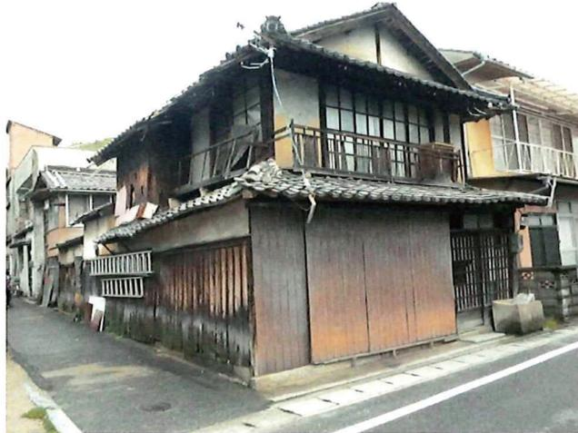
③基礎、土台、柱又ははりの腐朽、破損又は変形が広範囲に渡り、著しく崩壊の危険のあるもの(100点)
