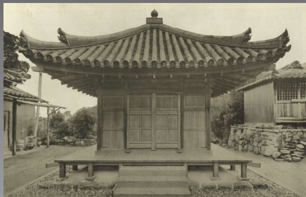
解体修理工事を終えた定光寺観音堂（昭和55年撮影）
