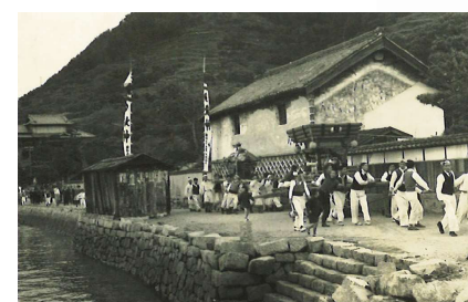
① 庄屋田頭家・本陣跡 (昭和31年頃撮影) 江戸時代、上弓削港は今治藩が参勤交代を行う際の寄港地となったことから、藩主の滞在用に御茶屋と呼ばれる本陣が設けられました。
