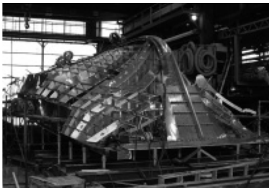
▲新救急艇「ゆうなぎ」建造状況（船底） 平成17年11月30日現在
