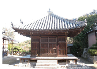
定光寺観音堂 (弓削土生地区)
