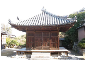
定光寺観音堂 (弓削土生地区)
