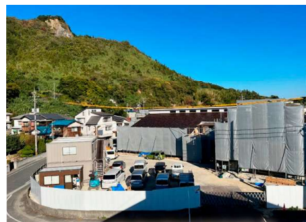
《 着工後（令和5年11月時点） 》
