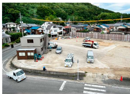
《 着工前（令和5年7月時点） 》
