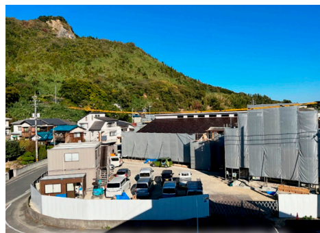
《 着工後（令和5年11月時点） 》
