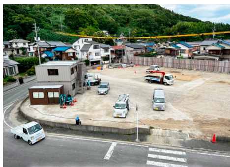
《 着工前（令和5年7月時点） 》
