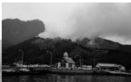
▲発生間もない延焼状況 (長江港沖より)
