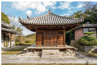
▲ 写真：定光寺観音堂（国指定重要文化財） 解体修理の際に、「寛正四年」と墨書された屋根の野地板が発見されました。荘園時代末期における島民の信仰の拠点だったとみられます。
