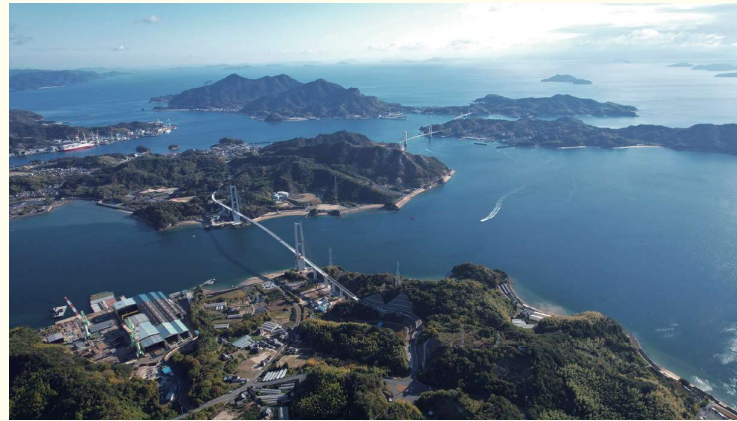
【佳作】「岩城橋と上島町」 上島町 松浦 功 様 なお、松浦 功 様の写真は切手部分ではなく、フレーム上部の 写真として使用させていただきます。
