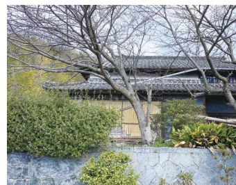
改修中の家屋
