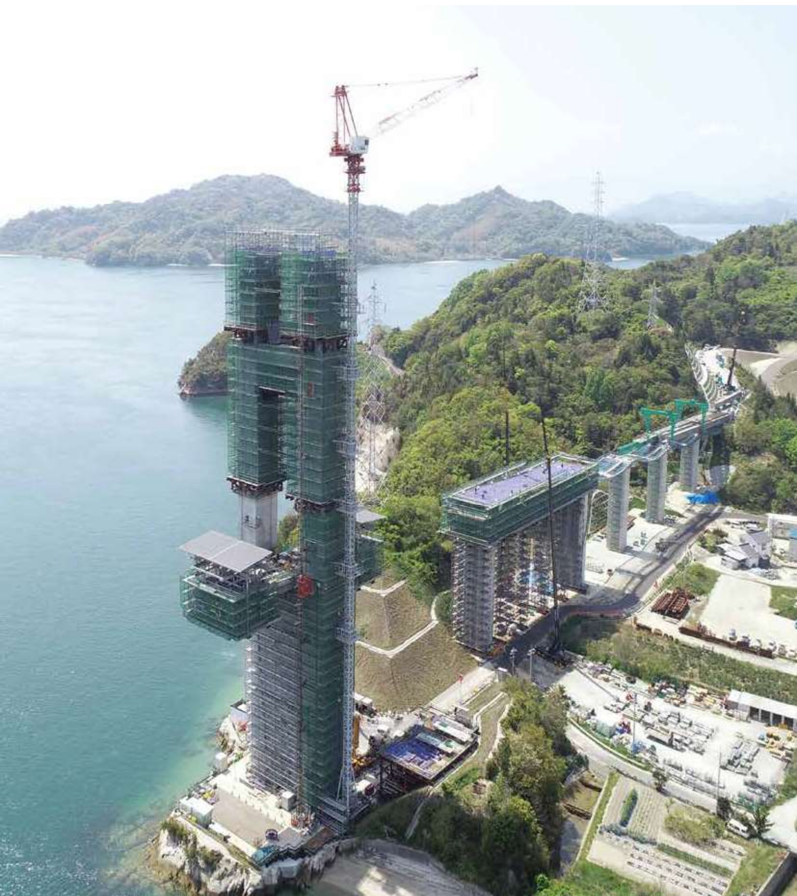
写真説明：岩城橋の工事現場
