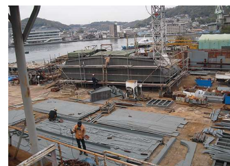
建造工事の進捗状況
