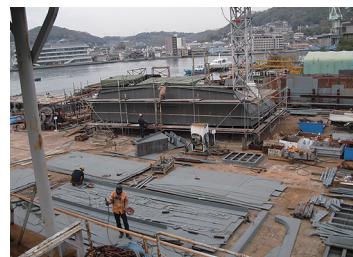
建造工事の進捗状況
