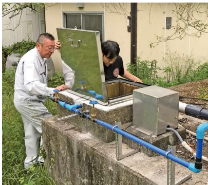
生活環境課による上水道施設の点検（弓削）
