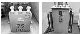
高圧コンデンサ例 高圧トランス例
