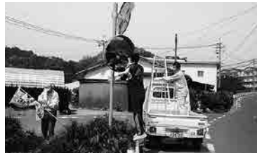
岩城地区・点検清掃
