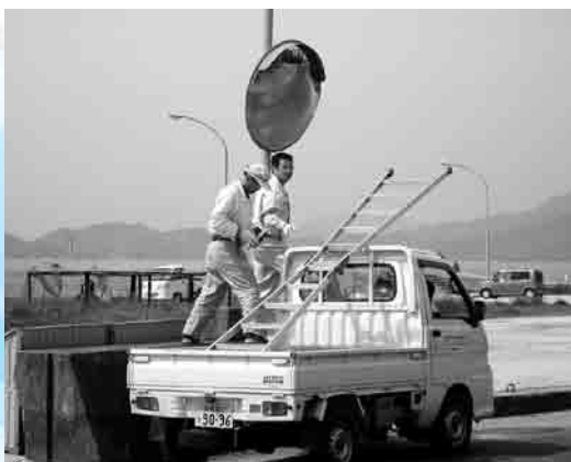
岩城地区でのカーブミラー点検
