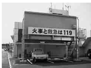
デジタル無線局舎設置状況
