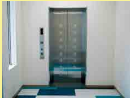
整備されたエレベーター
