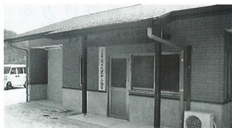
新築完成した上島町獣肉処理加工施設
