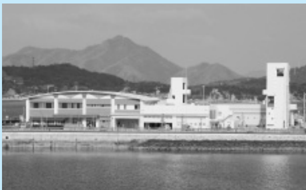
完成間近の消防庁舎 (3月8日撮影)
